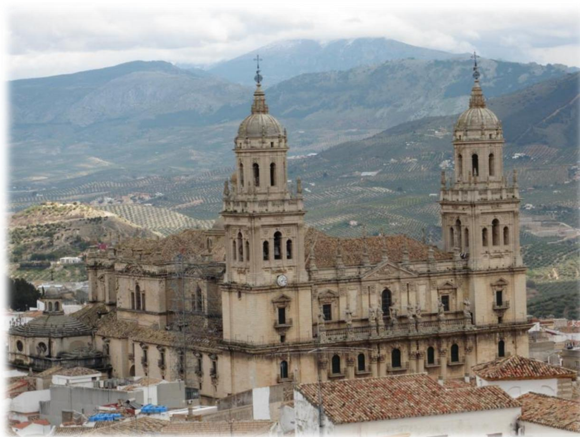
Bouwmeester Vandelvira begon in 1540 met de bouw van de kathedraal die een plaats kreeg aan de Plaza Santa María. De bouw van de kathedraal sleepte aan tot in de 18e eeuw.
