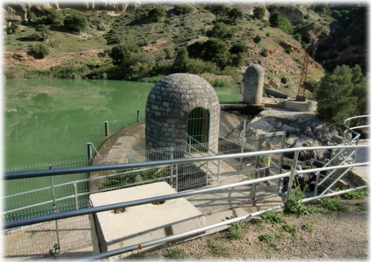
De rivier Guadelhorce loopt door El Chorro. Boven op de berg heeft men een stuwdam gebouwd om elektriciteit te produceren. Als er weinig vraag is naar elektriciteit, zoals 's nachts, haalt men water uit de rivier en wordt het water overgeheveld naar de stuwdam.
