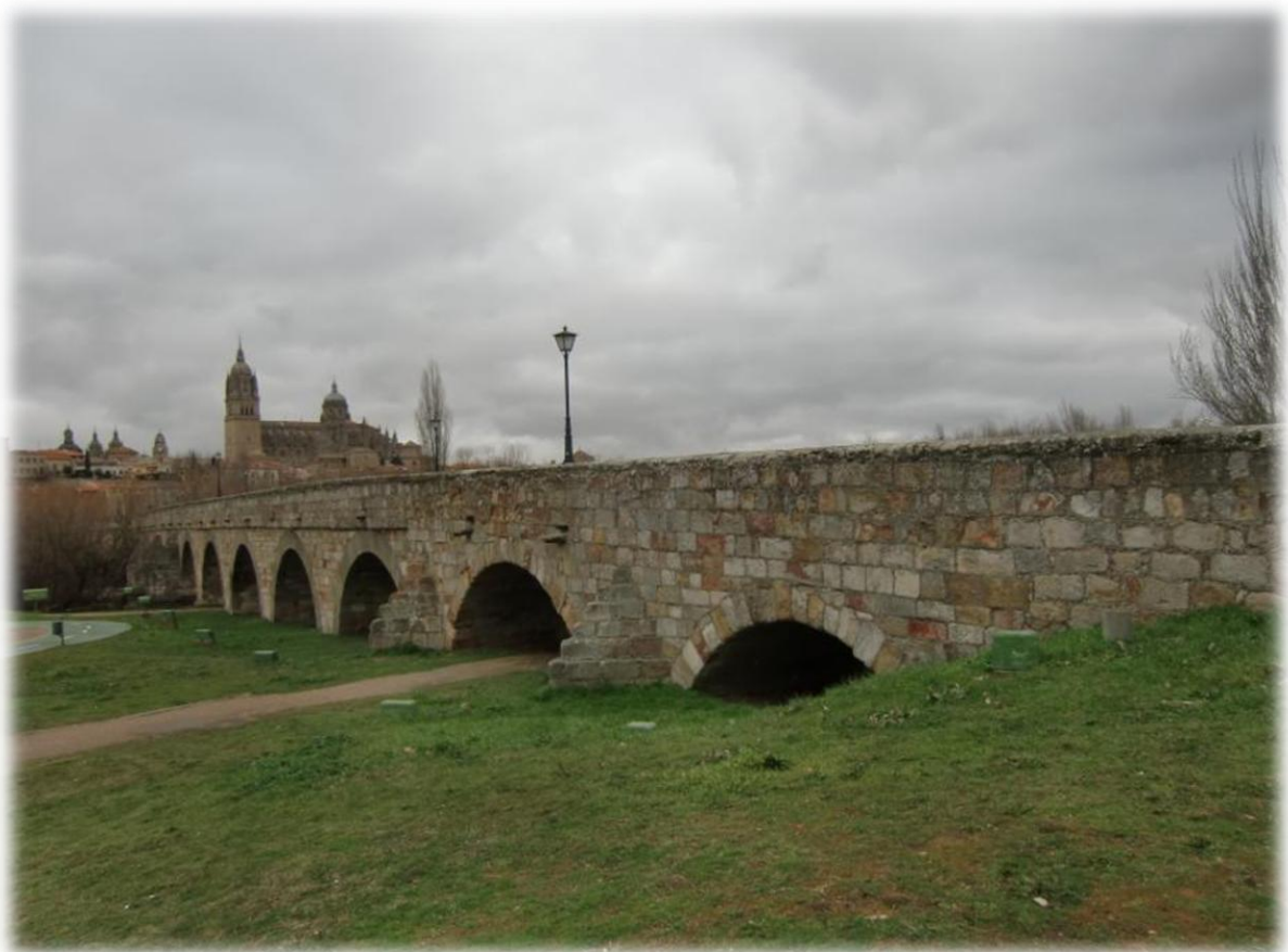
De Puente Mayor del Tormes is een brug met 26 bogen en dateert uit de Romeinse tijd. De datum van de bouw van de brug is niet precies bekend, maar is gelegen tussen de mandaten van de keizers Augustus (27 v.Chr-14 n.Chr) en Vespasianus (69-79).
