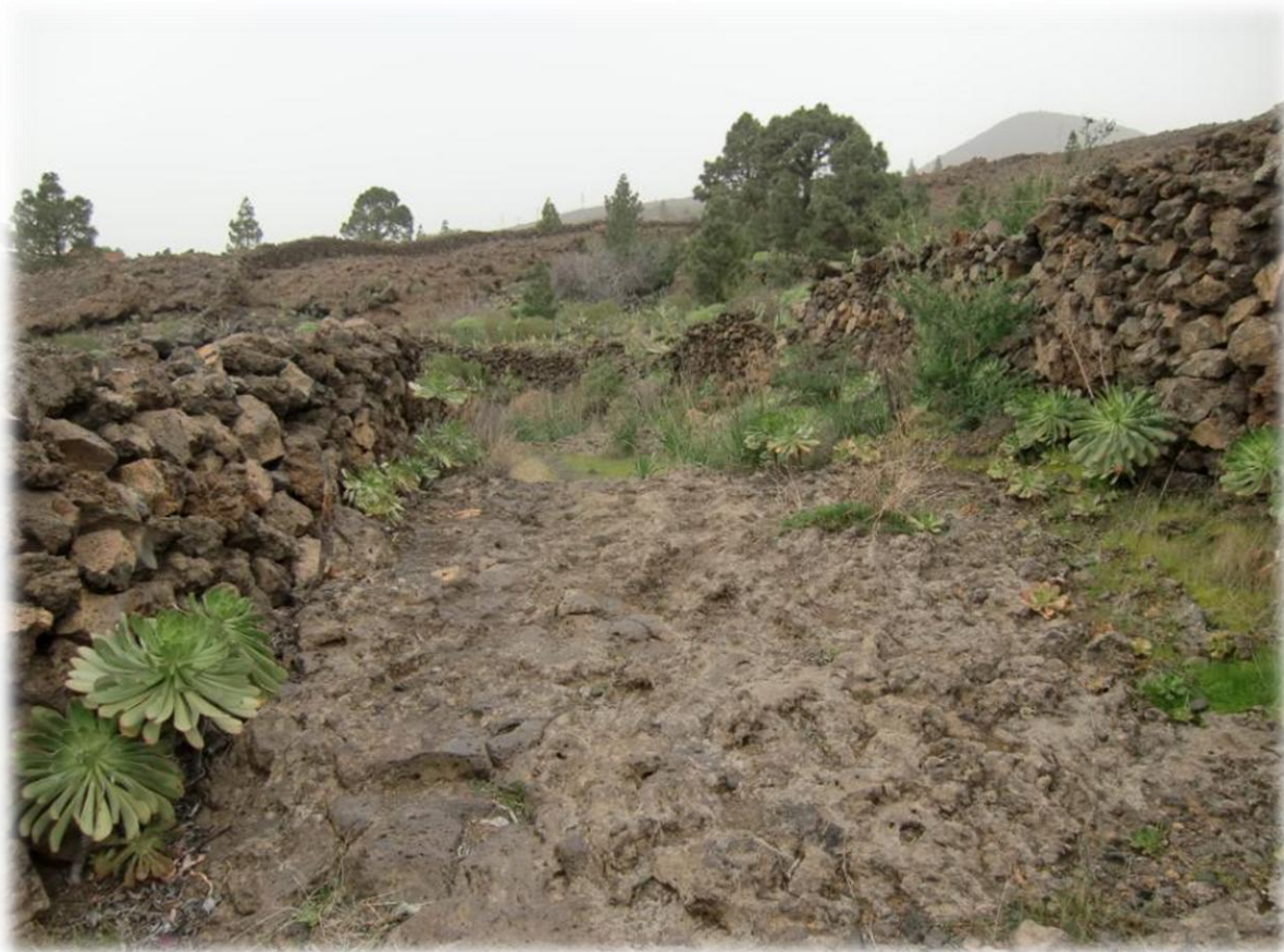
Eigendommen en paden worden hier veelal afgebakend met muurtjes vervaardigd uit los op elkaar gestapelde blokken lava.
