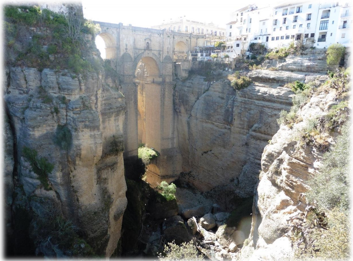
Ronda is ook bekend voor zijn drie bruggen, de Romeinse brug, de oude of Arabische brug en de nieuwe brug. De onderste foto is de “nieuwe brug”.
