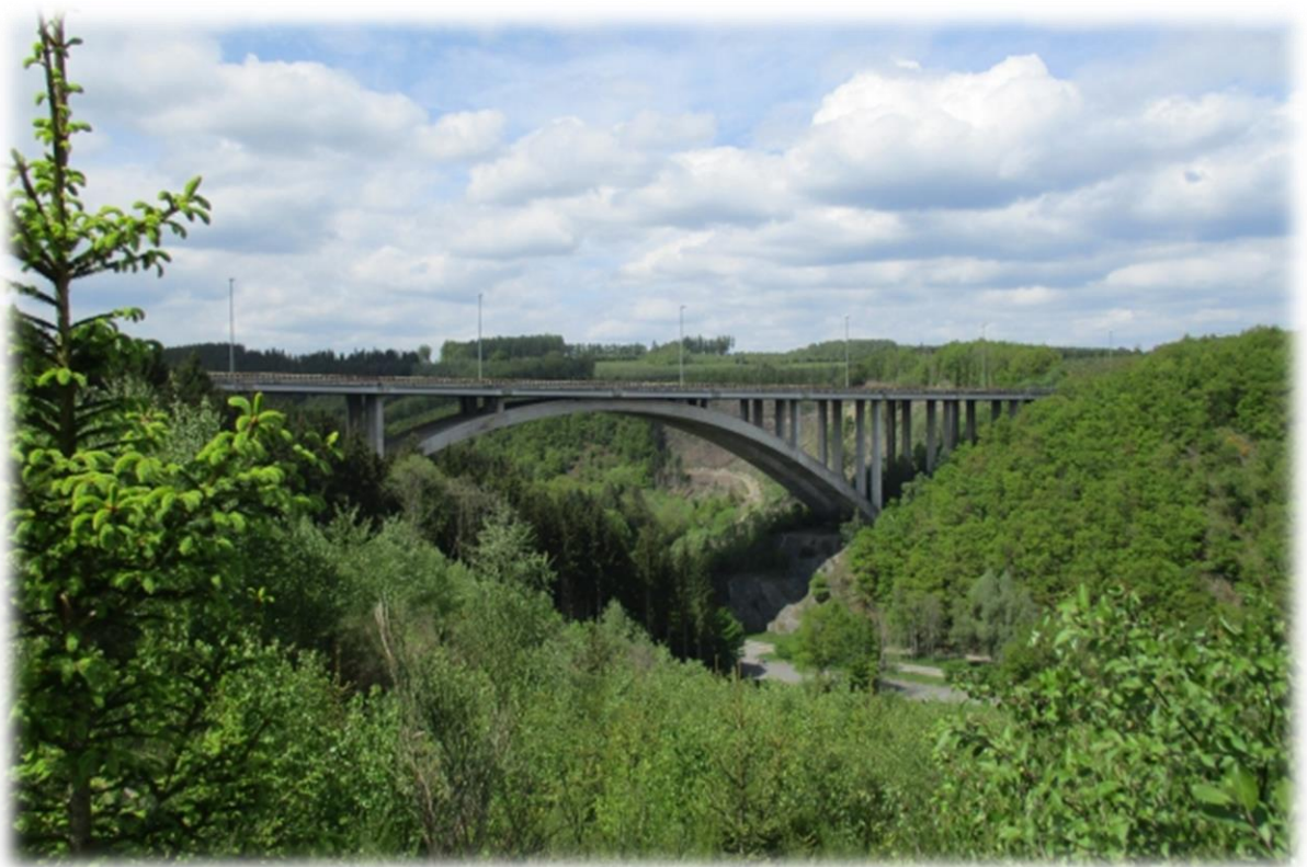
Sinds 1979 maakt een indrukwekkende constructie deel uit van het landschap rond Houffalize. Het viaduct van de E25 behoort tot de grootste in zijn soort in de bredere regio.
