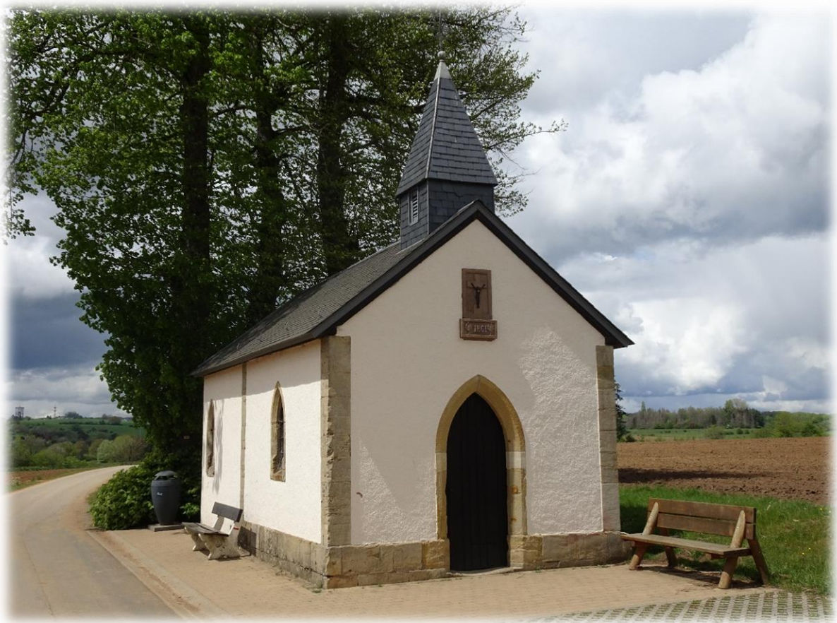
De eenzaam gelegen Rentertkapell is van oorsprong waarschijnlijk 17de eeuws, het huidige uitzicht is vooral het resultaat van restauraties in de 19de eeuw.
