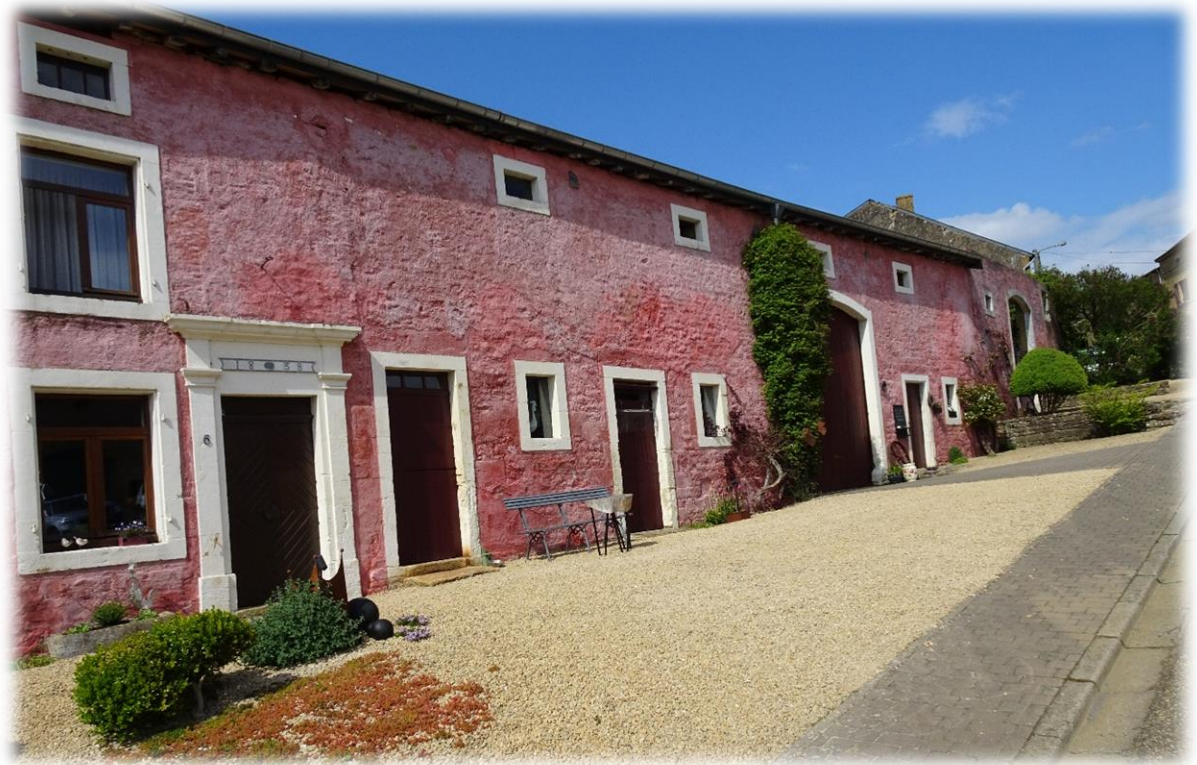
De gevel van deze boerderij is geen blote natuursteen maar draagt de oorspronkelijke bepleistering van zand vermengd met kalk die ze rozig hebben gemaakt met ossenbloed.
